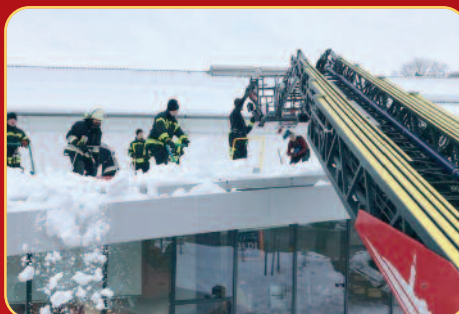
K-Einsatz Dach räumen Trostberg
